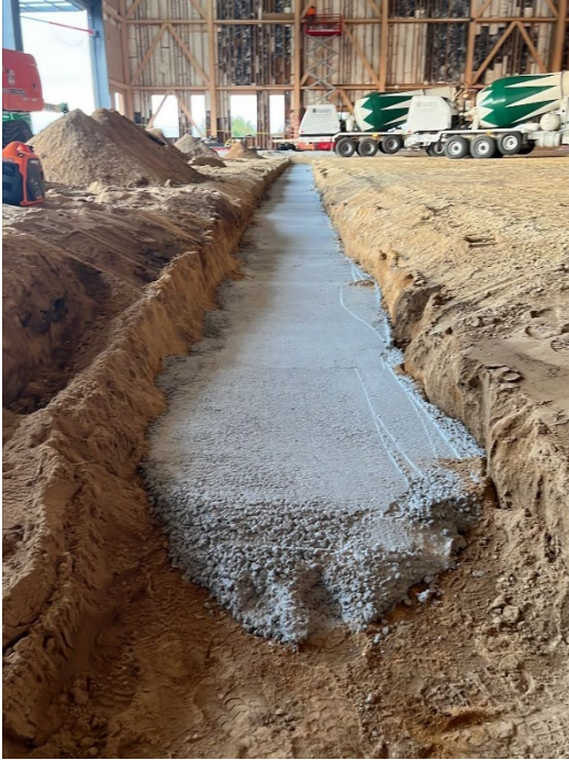
POUR BASE SLAB
