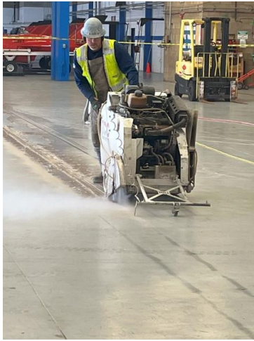
CORTAR A TRAVÉS DE LA LOSA
