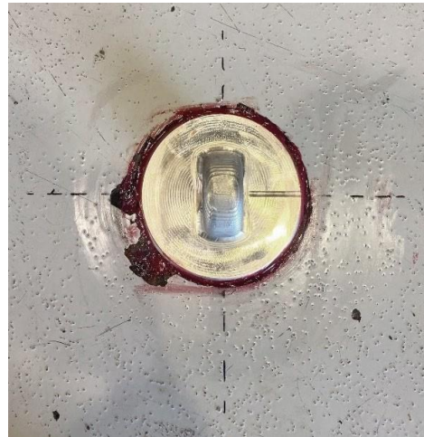
Figura 8-2: Punto de amarre ILDFA anclado químicamente a la losa de concreto
