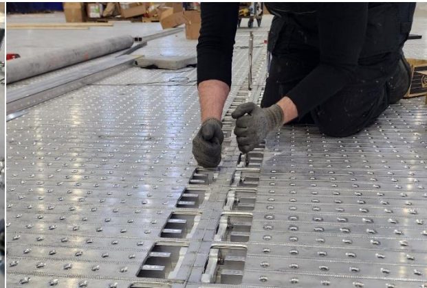
Figura 4-6: Proceso de instalación de la conexión de extremo a extremo
