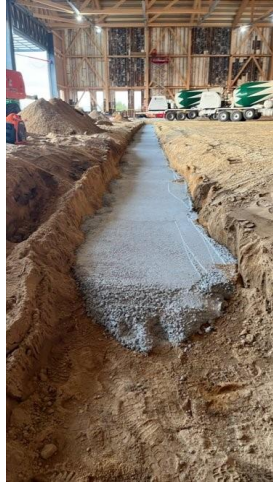
VERTER LODO/LOSA DE RATA
