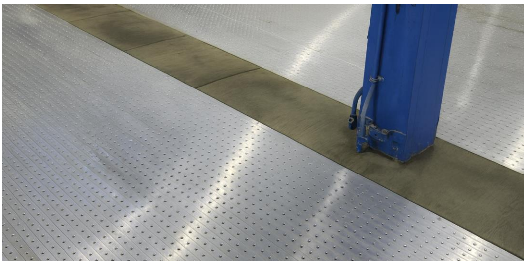
Figura 5-9: Ejemplo de relleno de concreto utilizado alrededor de los pilares en el centro del hangar.
