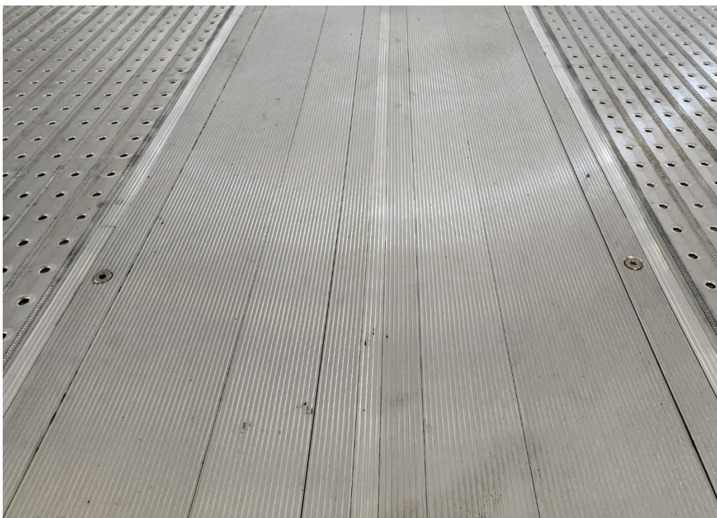
Figura 6-4: Instalación terminada de la tapa de la zanja.
