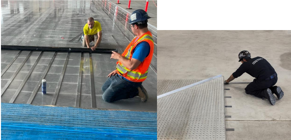
Figure 5-4 : Barre plate en aluminium utilisée pour le calage afin d'obtenir la pente requise lors de l'installation
