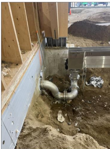
RACCORDER LA CONDUITE DE DÉCHARGE
