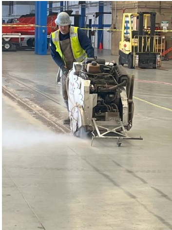
COUPER À TRAVERS LA DALLE
