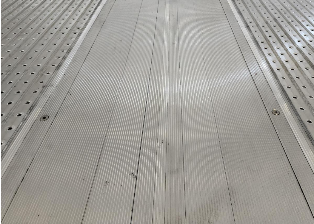
Figure 6-4 : Installation finalisée du couvercle de caniveau.
