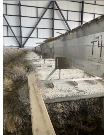
METTRE EN PLACE / ALIGNER LE CANIVEAU
