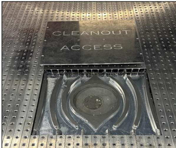
Figure 8-11 : Ouverture pour utilités avec couvercle retiré
