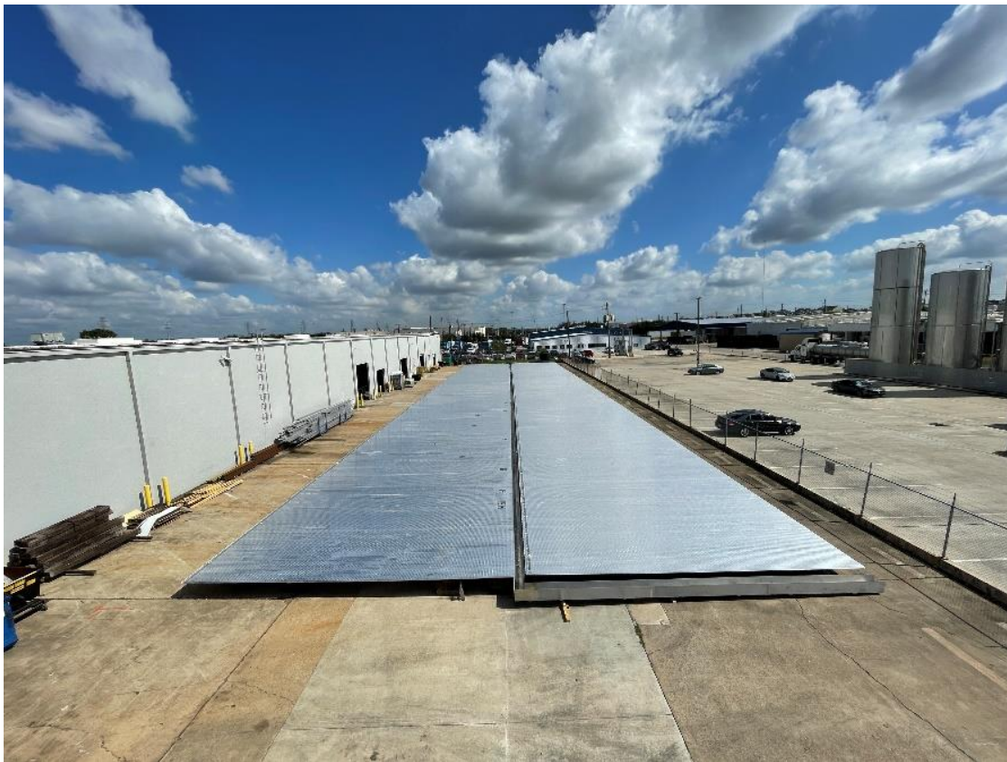
Figure 17-1 : Test du détecteur de flamme réalisé sur l'ILDFA illustré.
