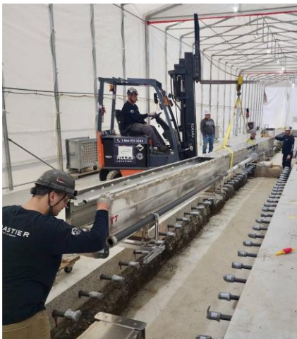
METTRE EN PLACE / ALIGNER LE CANIVEAU
