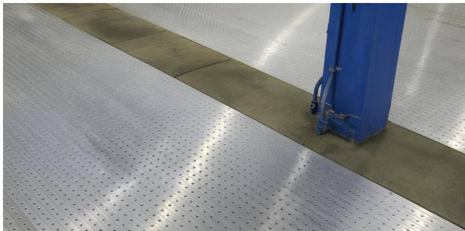
Figure 5-9 : Exemple de remplissage béton utilisé autour des colonnes au centre du hangar.
