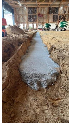
COULER LA DALLE DE PROPRETÉ
