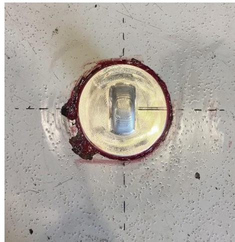
Figure 8-2 : Point d'arrimage ILDFA ancré chimiquement dans la dalle en béton
